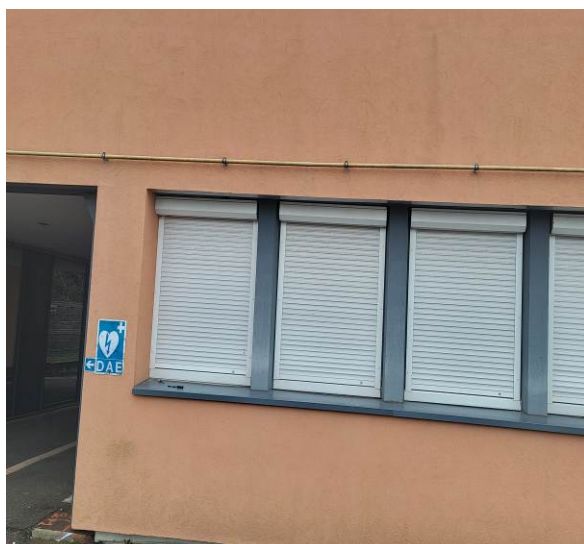
Salissures de la couche de finition de la façade Nord.
