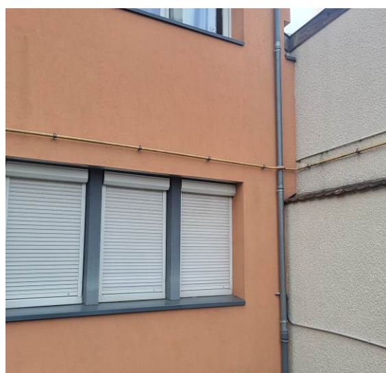
Salissures de la couche de finition de la façade Nord.
